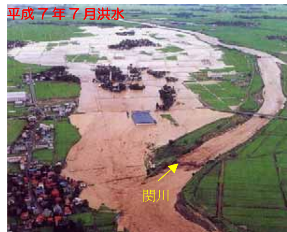
妙高市月岡地先破堤状況（旧新井市）
