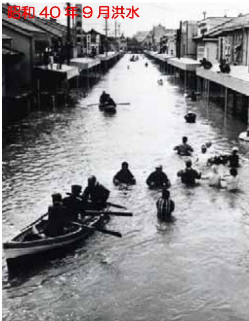
直江津駅前浸水状況
