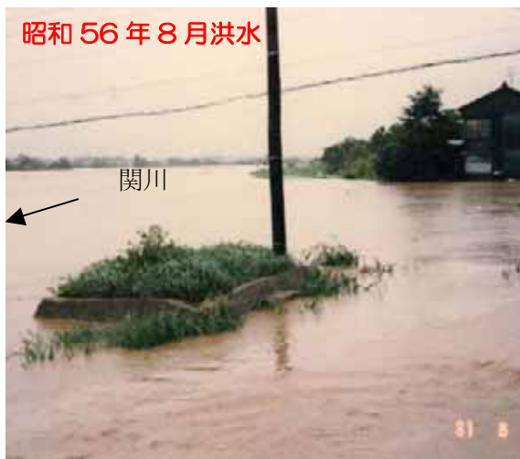
稲田橋上流左岸溢水状況（北城町付近）
