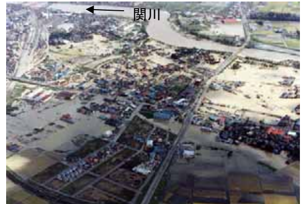
関川大橋付近の浸水状況
