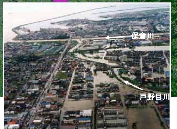
戸野目川沿川被害状況（上流から下流を撮影）
