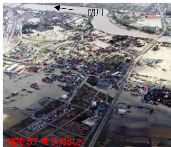
上空より関川大橋を望む
