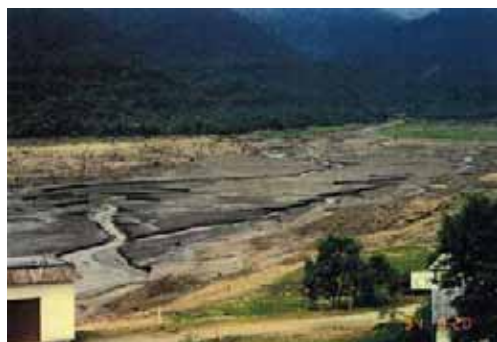
笹ヶ峰ダム貯水池の枯渇状況 (H6 妙高市 (旧妙高高原町))
