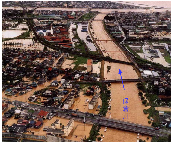
平成7年7月洪水の状況
