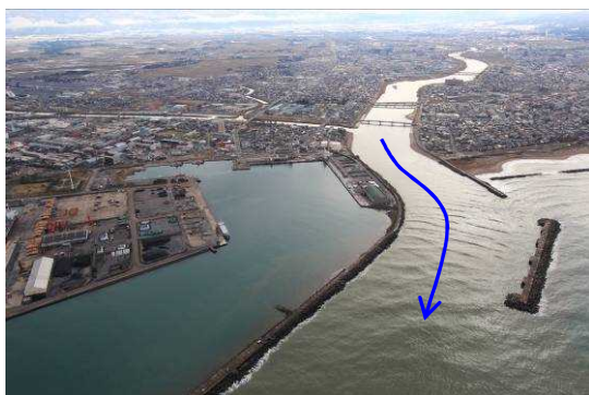
関川河口部の状況
