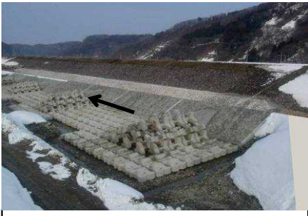
急流河川対策 (S44~) 洪水により洗掘された箇所において護岸を整備
