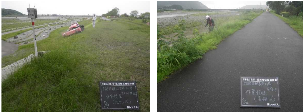
図-5.2 堤防除草状況図（機械による除草と肩掛け式草刈り機による除草）
