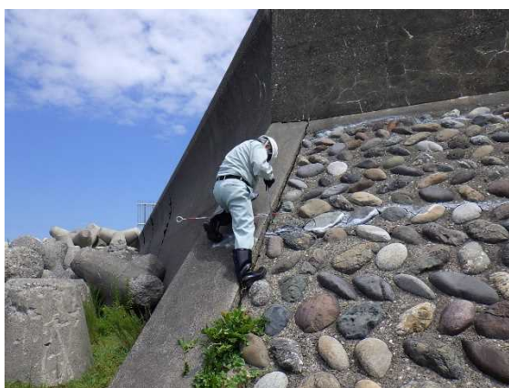
図-5.4 平常時の河川巡視（護岸の目地の開き調査と対岸からの変状目視）
