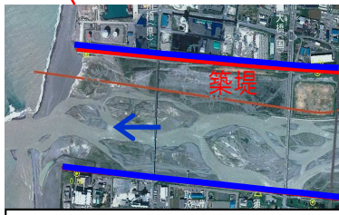
築堤護岸工事 (S44~) 流路の安定化と堤防補強
