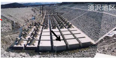
急流河川対策 (H13~) 護岸整備を実施
