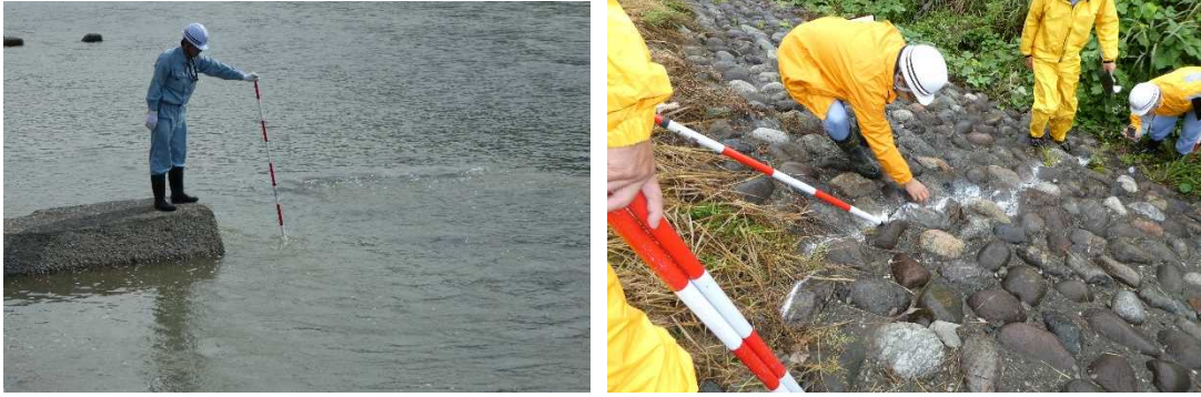
図-5.7 台風期前の堤防点検（平成 28 年）
