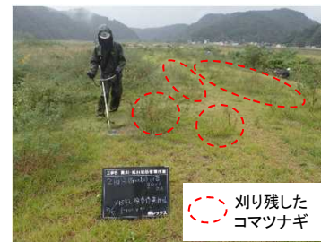
群生しているコマツナギを刈り残した堤防除草作業
