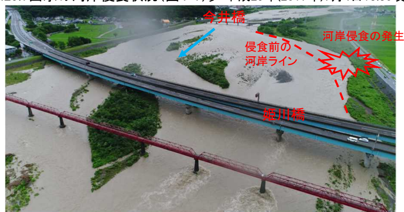
左岸2.2k+10～70m付近(河岸侵食)発見時刻:平成29年(2017)7月4日 8:00頃
