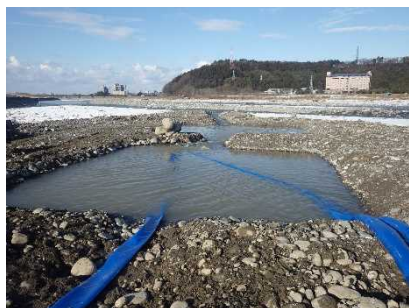
沈砂池の設置
