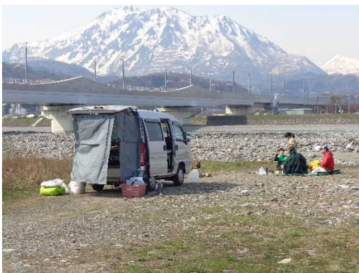
〔河川敷地の適正な利用(寺島地区護岸整備箇所)(図3-10)〕
