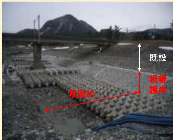
護岸の根継の状況（埋戻し前）
