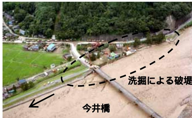
河岸洗掘による破堤状況（糸魚川市上刈地先）
