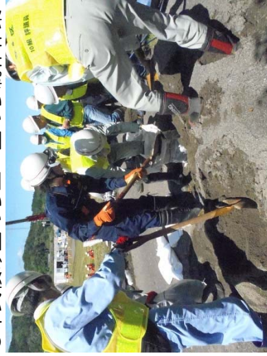
●市民積み土のう工－土のう制作作業
