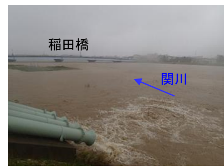
水戸の川排水機 吐出口
