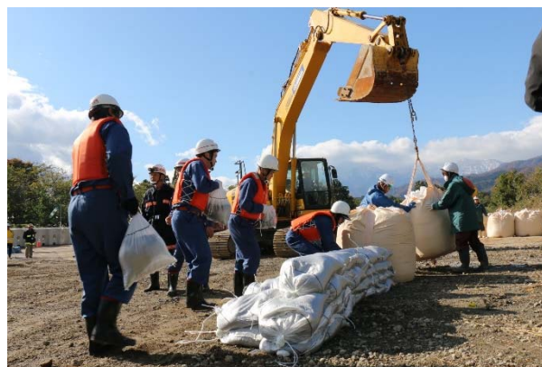
妙高市建設業親和会による大型土のう積み工法
