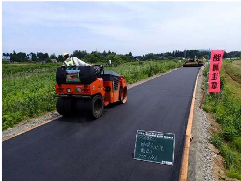
保倉川 堤防舗装
