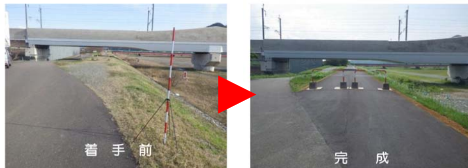
堤防天端の保護：糸魚川市須沢地先
