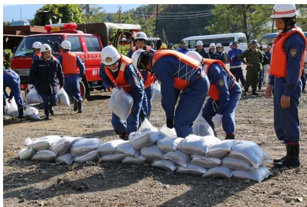
消防団による積み土のう工
