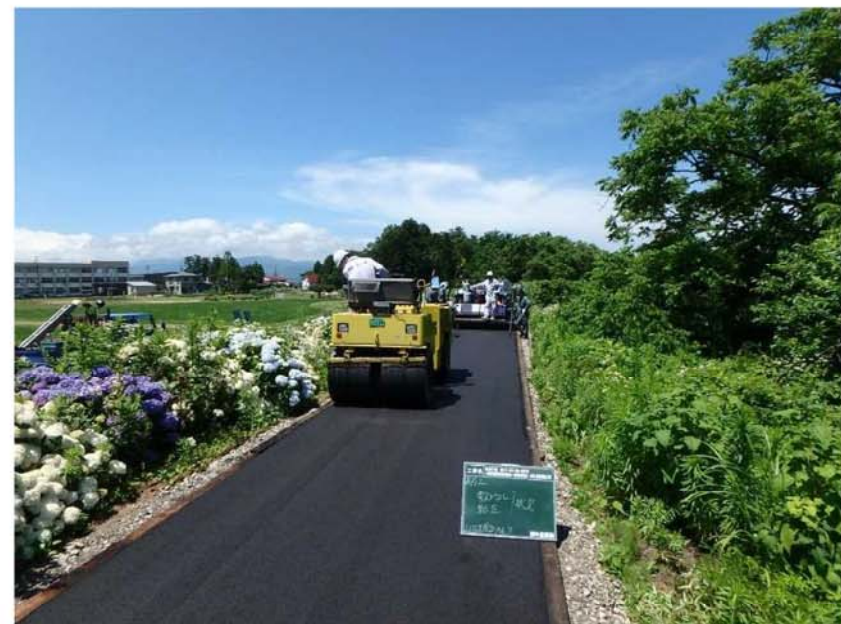
飯田川 堤防舗装
