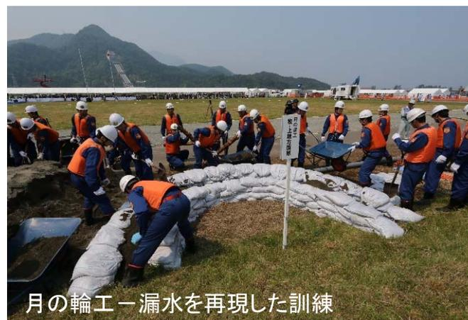
月の輪工一漏水を再現した訓練
