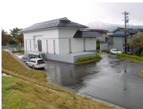
【上越消流雪用水機場】
