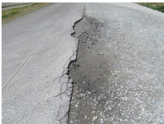
堤防天端舗装の段差解消措置写真(姫川)
