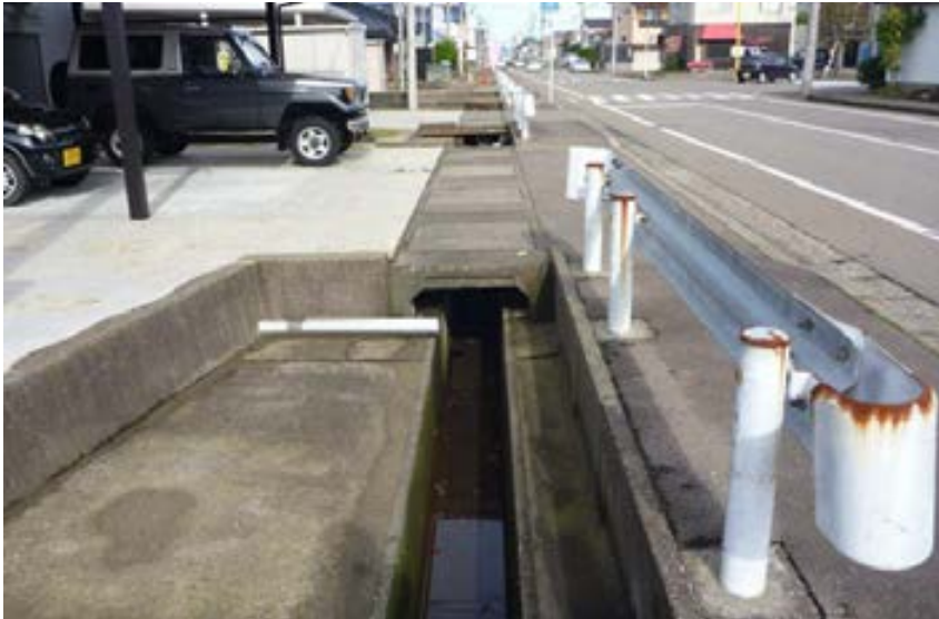
ふた そっこう 蓋のない側溝
