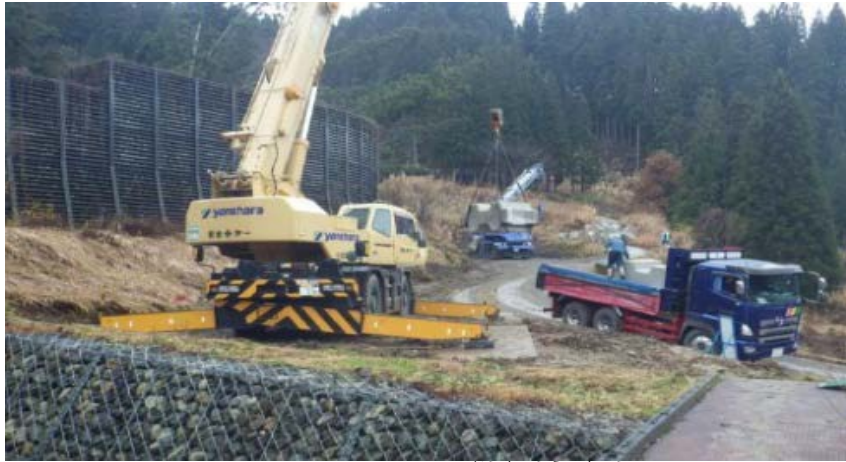
【災害支援】 応急復旧
