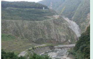
7 崩壊・土石流の現場(姫川溪谷ジオサイト)
