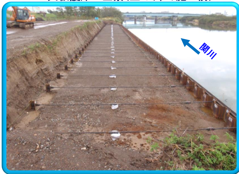
矢板護岸工全景(笠コンクリート施工前)
