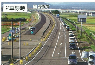
岡原交差点の混雑状況 (下り線 平成25年9月18日)
