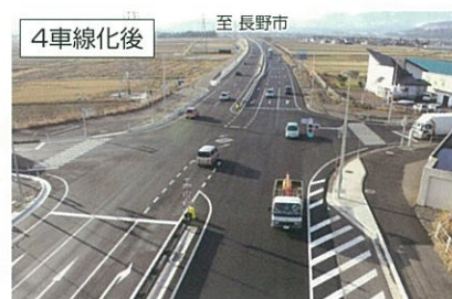
岡原交差点の状況 (下り線 平成26年1月8日)
