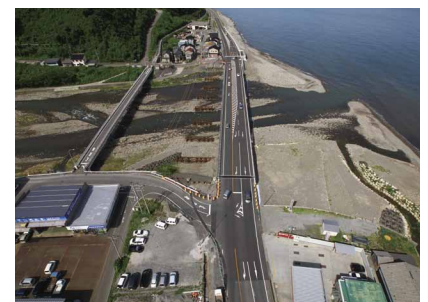
橋梁架替が完了した能生大橋
