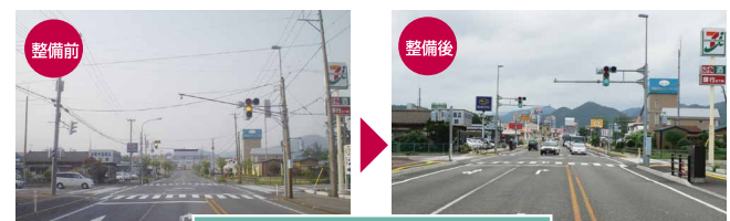
国道8号寺島電線共同溝の整備
