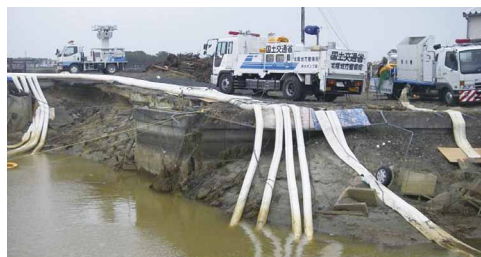
排水ポンプ車・照明車(宮城県亘理郡亘理町)
