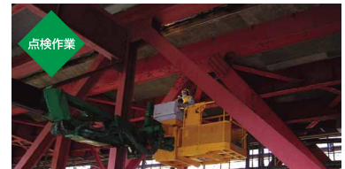
橋梁点検(国道18号 郷田切橋)
