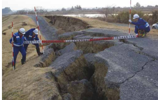
東日本大震災(H23.3)での現地調査状況
