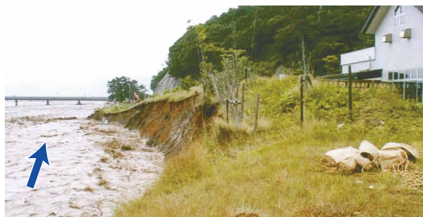
平成7年7月 姫川出水 糸魚川市大野地先 堤防欠損状況
