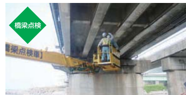
橋梁点検(国道8号 青海川橋)
