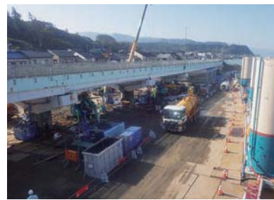
架替工事が進む弁天大橋
