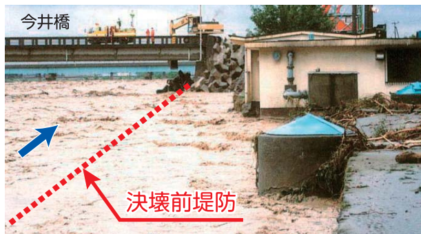
平成7年7月 姫川出水 糸魚川市上刈地区の堤防決壊状況
