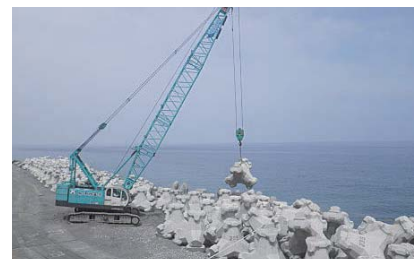
防災対策(国道8号糸魚川市勝山地先)
