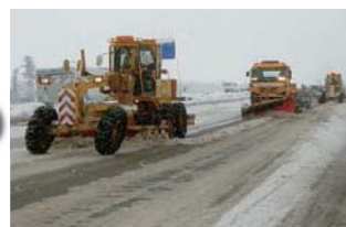
除雪車による除雪状況(国道18号)
