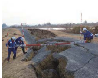
東日本大震災(H23.3)での現地調査状況
