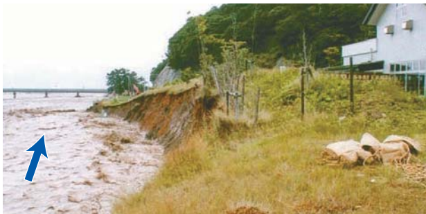
平成7年7月 姫川出水 糸魚川市大野地先 堤防欠損状況
