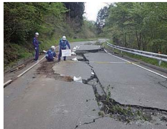
熊本地震(H28.4)での現地調査状況
