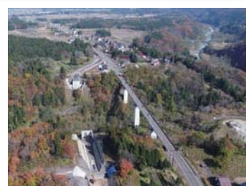
新橋の架替工事が進む妙高大橋
