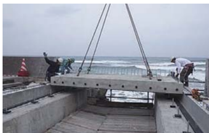
塩害橋梁更新(国道8号宮ノ平橋)
