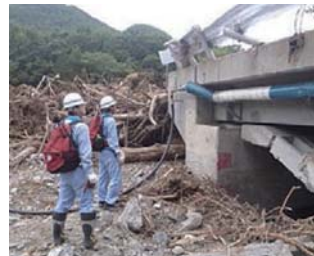
台風10号災害(H28.9) 岩手県岩泉町での現地調査状況
