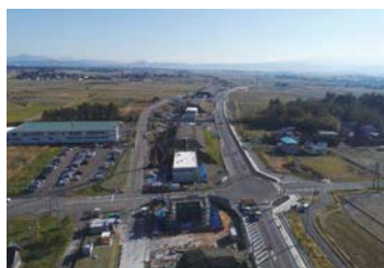
工事が進む上越三和道路
