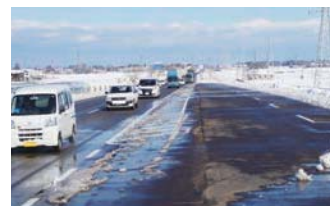
チェーン着脱場の設置(国道18号 上箱井)
