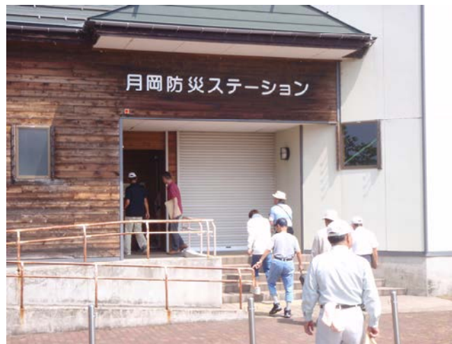
●防災ステーション
