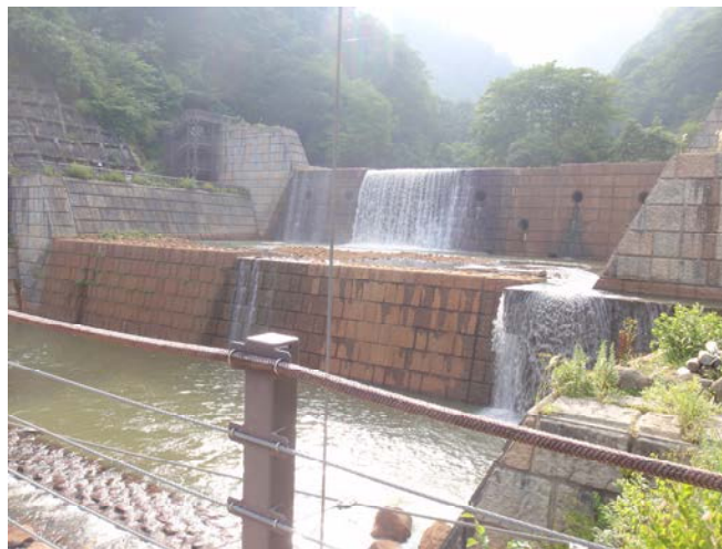
●関川第一号砂防堰堤
