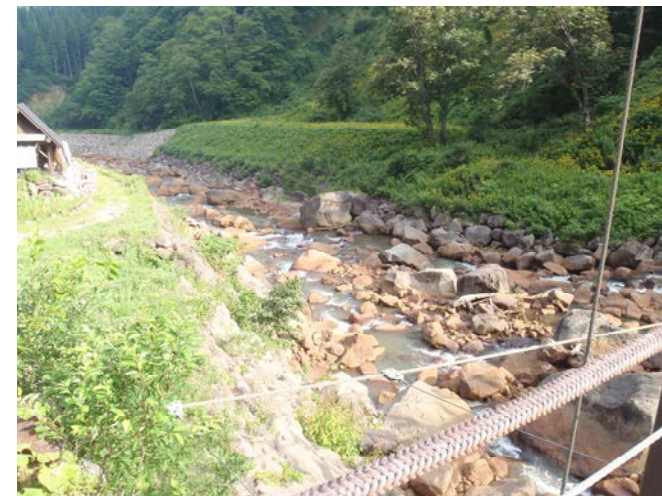
●関川第一号砂防堰堤（下流河道状況）
