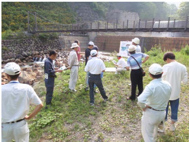
●関川第一号砂防堰堤（説明状況）
