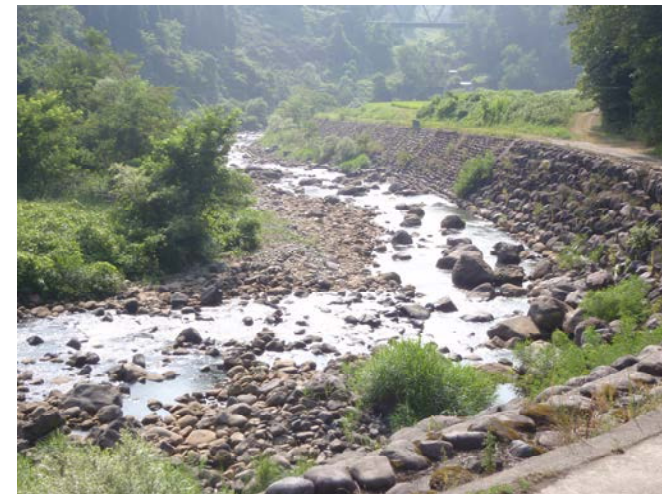
●蔵々発電所付近（下流方向）
