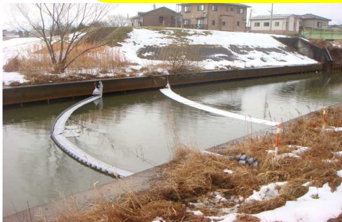
河川での水質事故時の被害拡大防止のための応急措置状況
