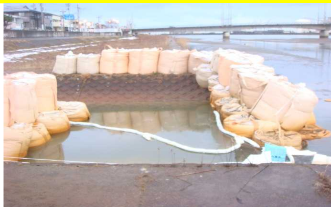
河川での水質事故時の被害拡大防止のための応急措置状況
