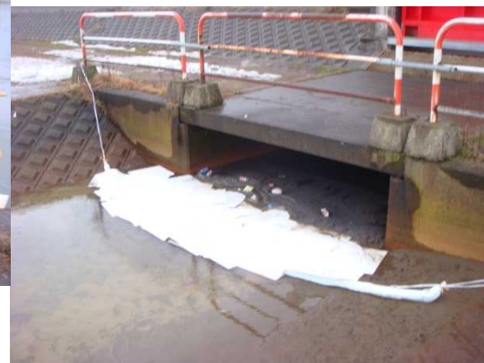
河川での水質事故時の被害拡大防止のための応急措置状況
