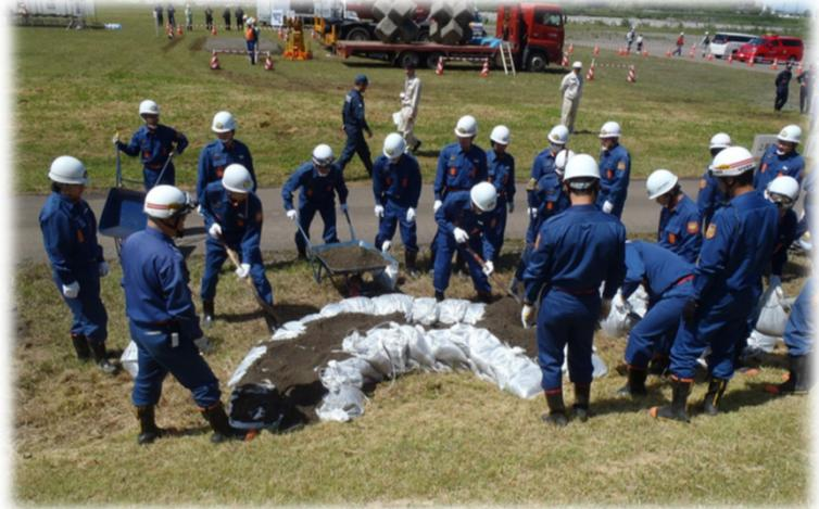
堤防からの漏水を弱める月の輪工
