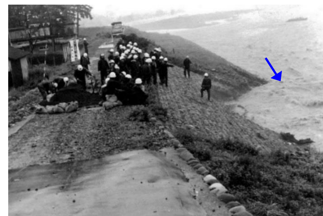
上刈地先の水防活動の状況 （木流し工に使用する土のうを製作）
