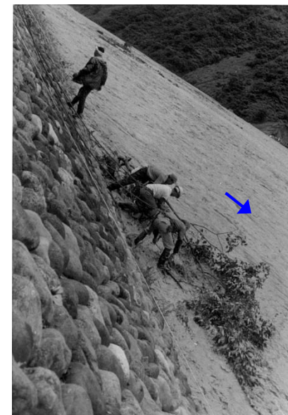
8月11日出水・姫川右岸糸魚川市根小屋地先の木流し工による水防活動 ねごや
