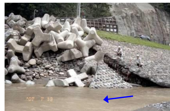
上刈地先の被災箇所 うえかり に異形ブロックを投入
