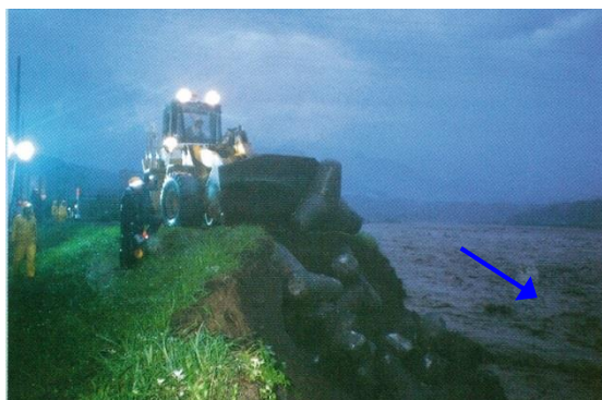
上刈地先の被災箇所 うえかり に異形ブロックを投入
