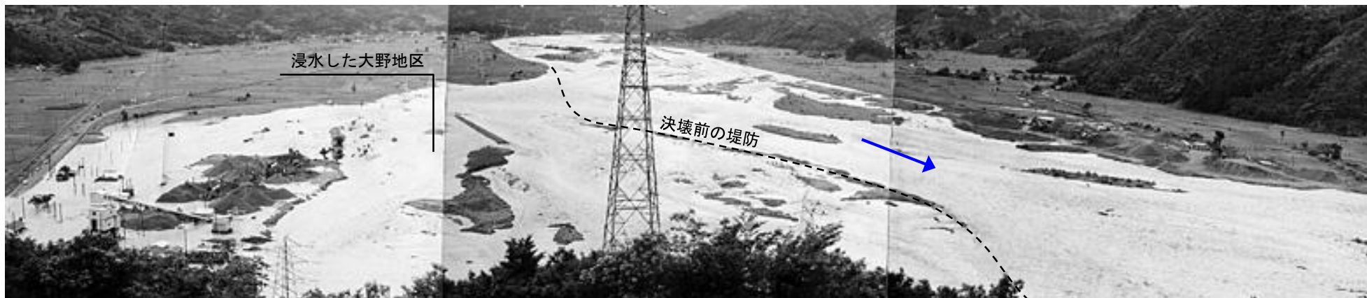
7月18日・姫川右岸糸魚川市大野地区の堤防が決壊
