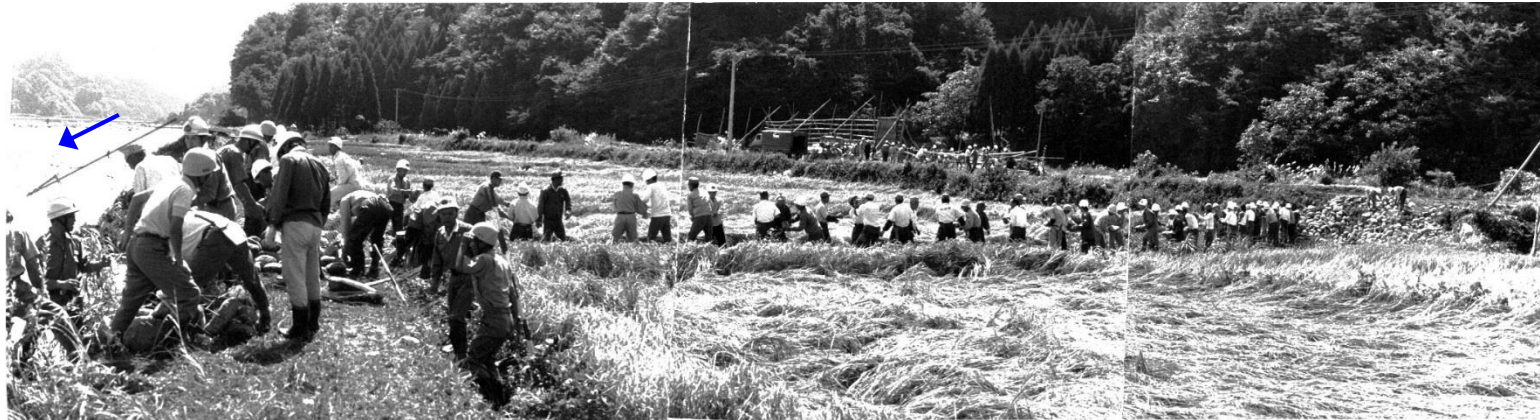
西川原地先の水防活動と応急処置の作業状況（堤防欠壊箇所に蛇籠を敷設するため、大勢の方が中詰め用の石を手渡しで運んでいる）
