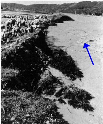
西川原地先の水防活動と応急処置の作業状況（堤防欠壊箇所に蛇籠を敷設するため、大勢の方が中詰め用の石を手渡しで運んでいる）
