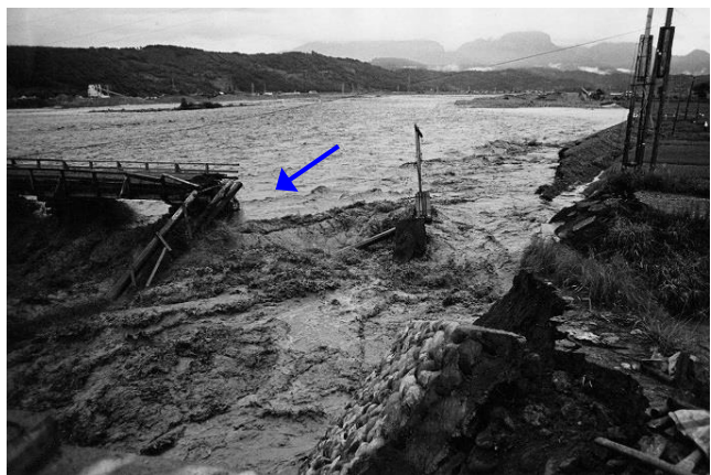
8月9日出水・押し流された今井橋 いまい
