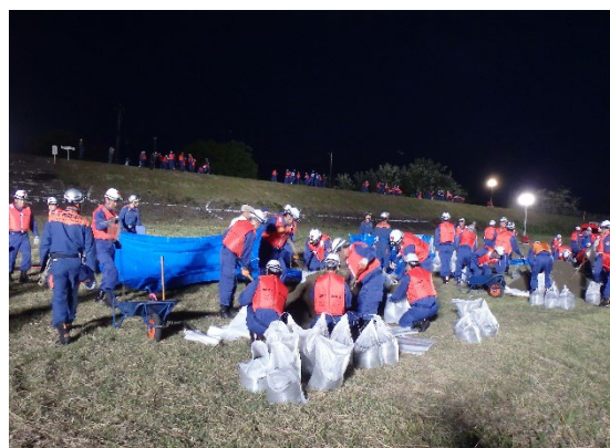
消防団員による改良積み土の 土工訓練の様子
