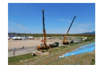
新潟県、国土交通省、北陸地方防災エキスパート及び災害時協定業者による応急復旧工（大型土のう工・ブロック投入工）
