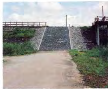
②堤防高水敷側階段
