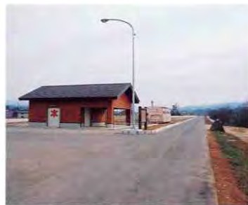
⑩トイレ施設及び堤防側帯駐車場
