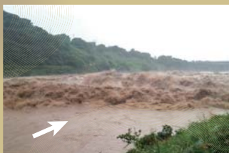
洪水を日本海へ流す大河津分水路 (第二床固附近)
