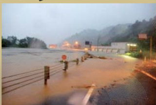
浸水により寸断された交通 (国道17号 魚沼市下島地先)
