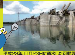
平成23年11月23日に通水した可動堰
