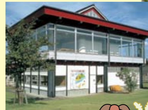
魚野川改修資料館
