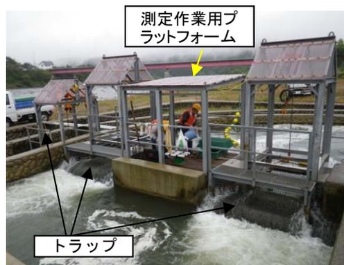
図-4 宮中取水ダム魚道のトラップ設置状況
