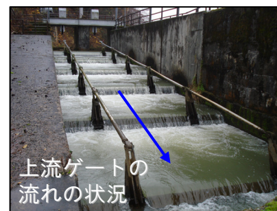
[上流ゲート部]
