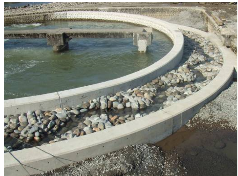
せせらぎ魚道施工完了箇所
