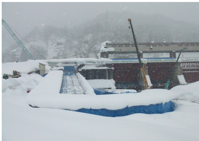
工事施工状況
