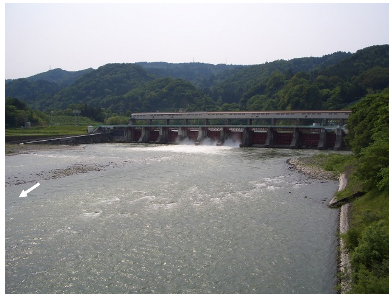
日平均放流量：237.7m 3 /s 撮影日：平成21年5月26日
