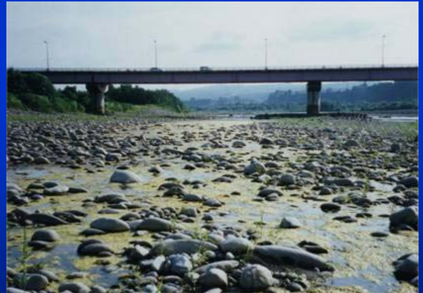
腐敗した付着藻類(妻有大橋付近)
