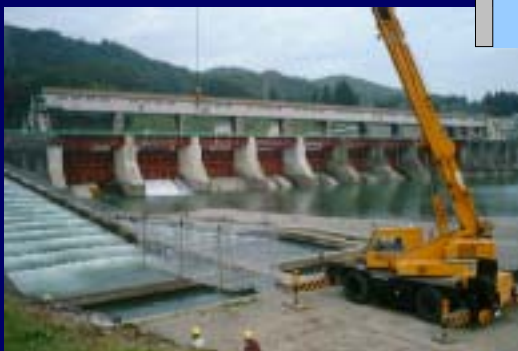
魚類誘導用の「トンガ」の設置
