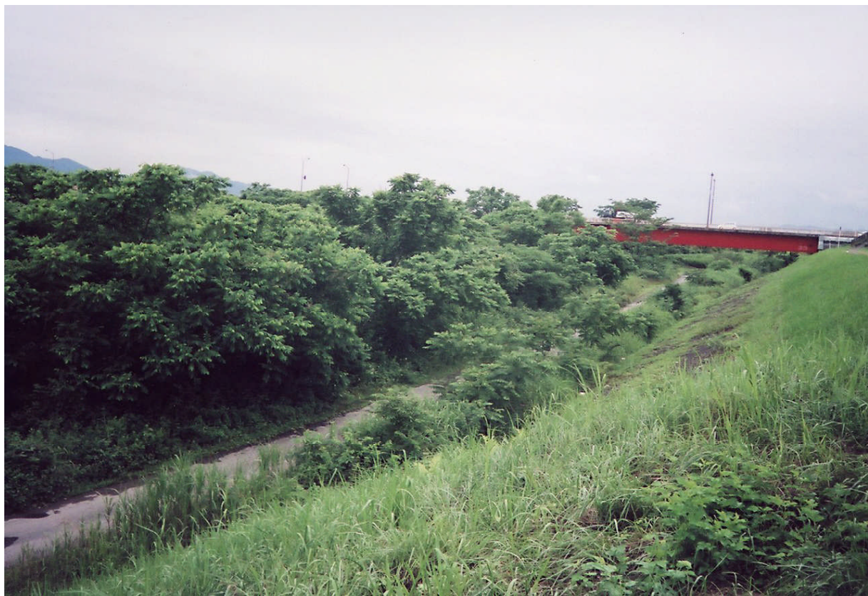
☆信信信1 長岡大橋付近 左岸 15.5～16.0km (左岸の堤防上から上流方向を望む)
