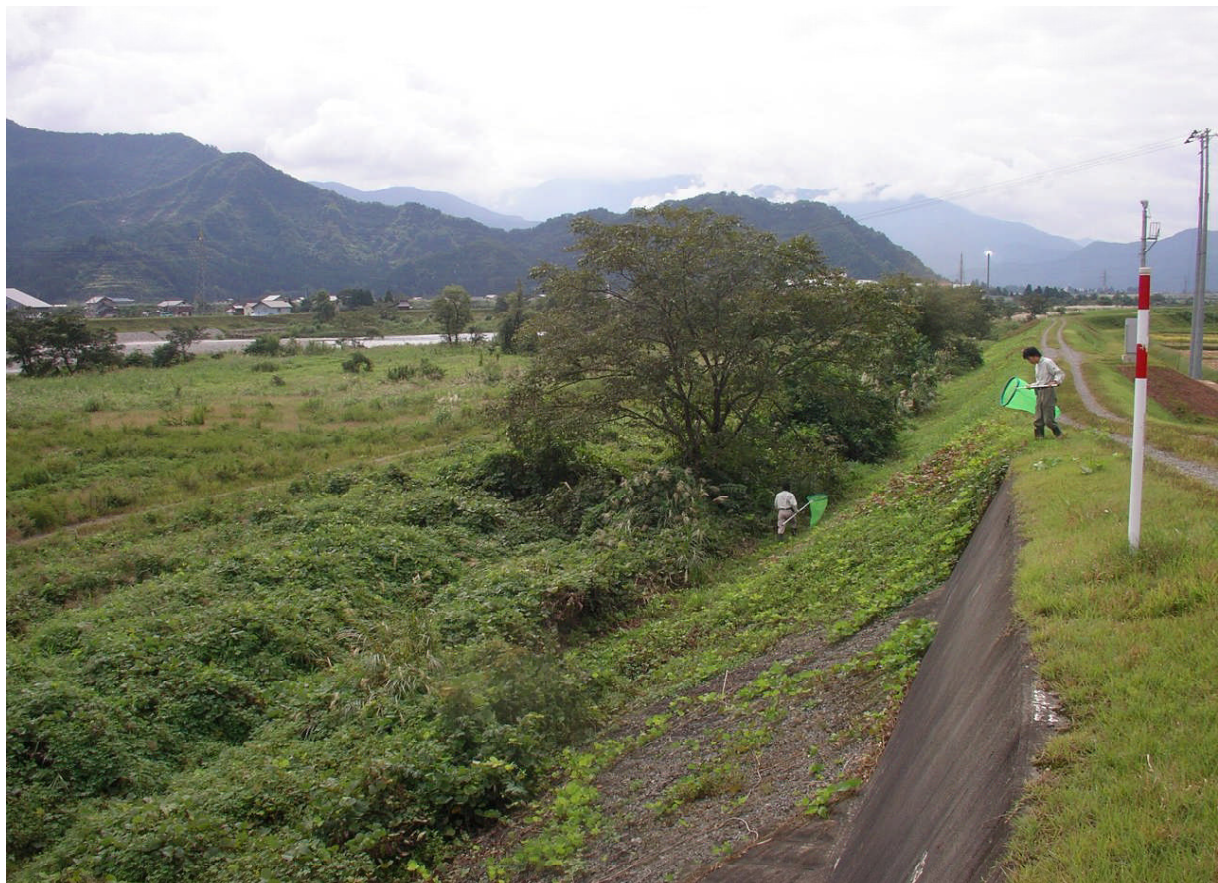
☆信魚信2 大和橋付近 両岸 25.0～25.5km (堤防上から上流方向を望む)
