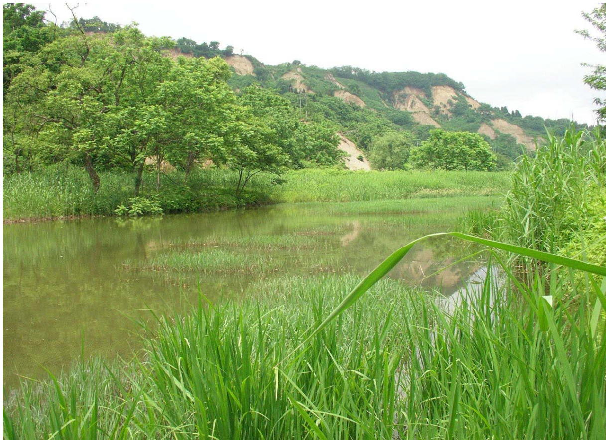
信信信5 牛ヶ島排水樋管対岸 左岸 39.5～40.0km (左岸から下流方向を望む)
