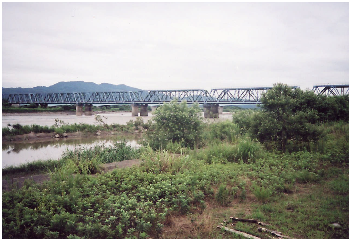
信信2 越路橋下流 左岸 23.3～24.0km (左岸から上流方向を望む)
