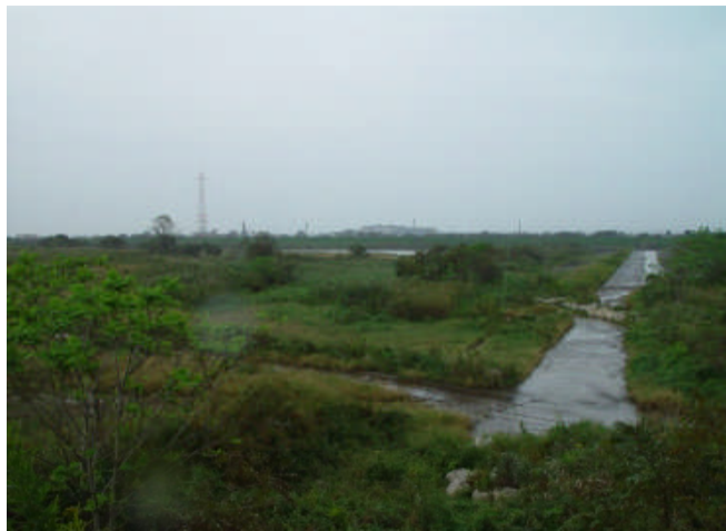
信大信F3 大河津分水路分岐点 左岸 0.0~1.0km (上流側から下流を望む)
