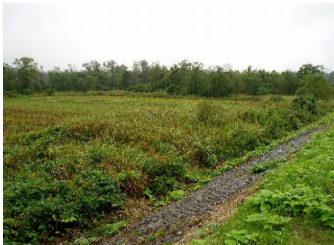
信信信F16 取安川合流 左岸 54.5~55.5km (下流側から上流を望む)
