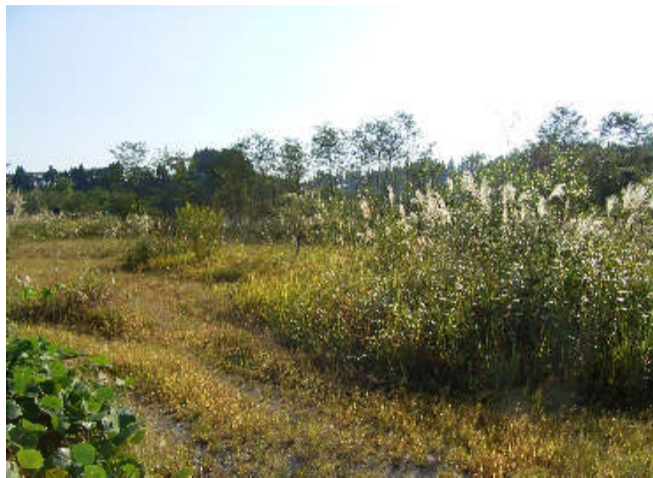
信信信F13 川井樋管付近 左岸 44.5~45.5km (堤防沿いから高水敷を望む)
