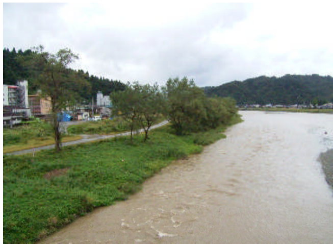
信魚信F3 小出橋下流 左岸 12.5~13.5km (小出橋から下流を望む)
