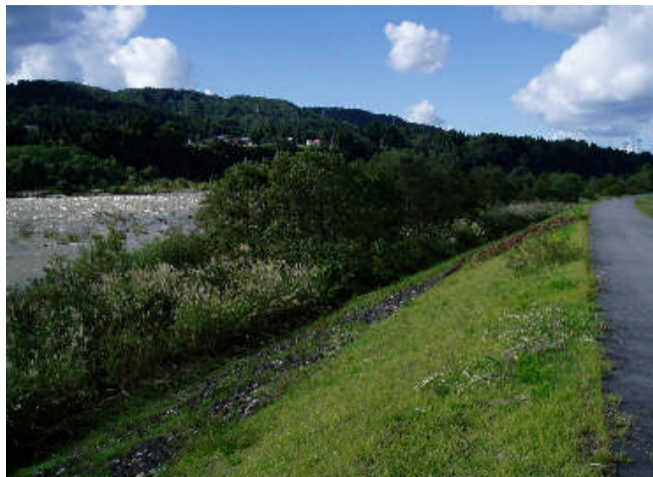
信信信F19 当間川合流 右岸 71.0~72.2km (上流側から下流を望む)
