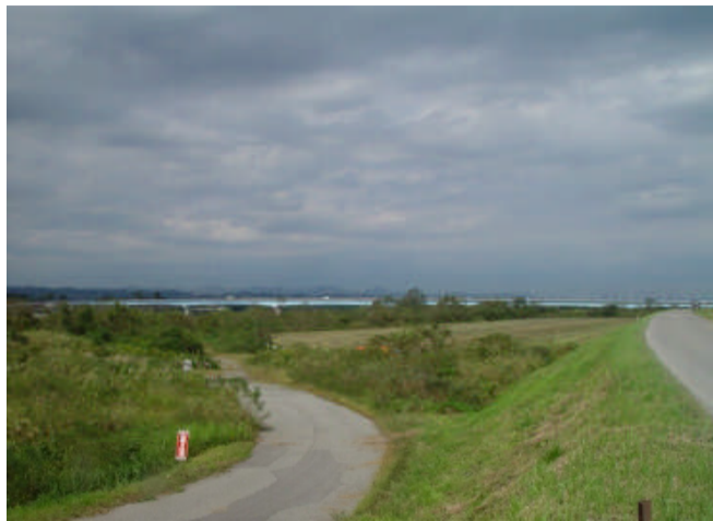
信信信F8 越路橋下流 右岸 23.0~24.5km (上流側から下流を望む)
