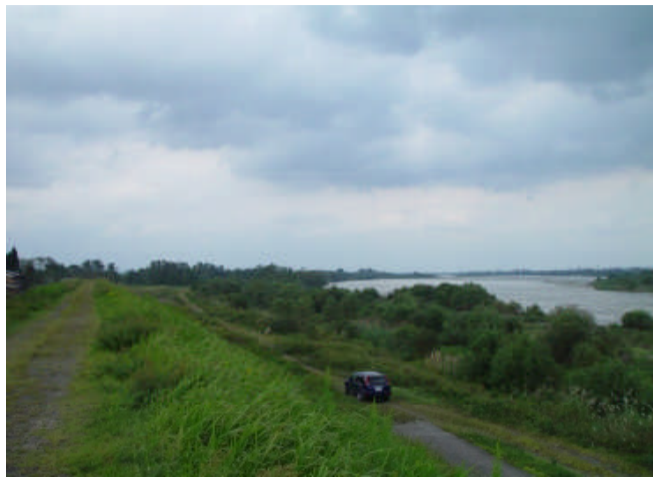
信信信F9 越路橋下流 左岸 22.3~24.0km (上流側から下流を望む)
