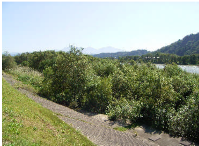
信魚信F2 芋川合流 右岸 6.2~7.5km (下流側から上流を望む)
