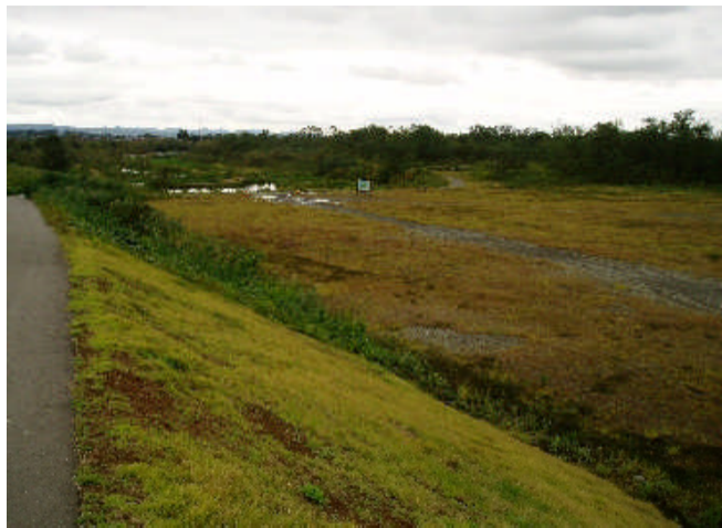
信信信F10 越の大橋下流 左岸 28.0~29.5km (上流側から下流を望む)
