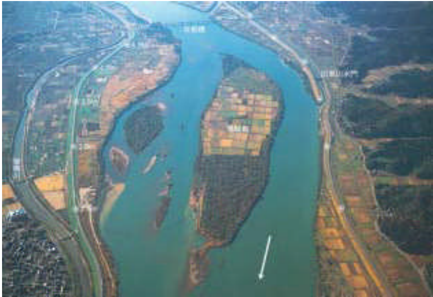
信信信1 与板橋 右岸 3.0~6.0km (下流から上流を望む)
