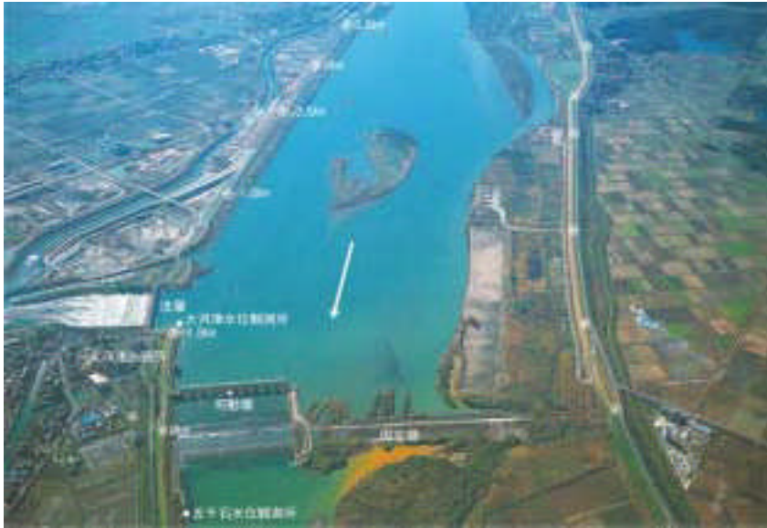
信大信3 大河津 右岸 -1.5~1.5km (下流より上流を望む)
