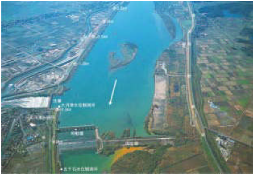
集団1 町軽井 左岸 0.0km (下流より上流を望む)
