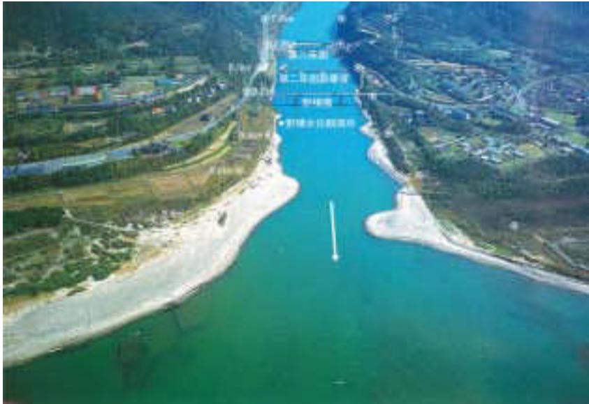
信大信1 白岩 右岸 9.0km (河口より上流を望む)
