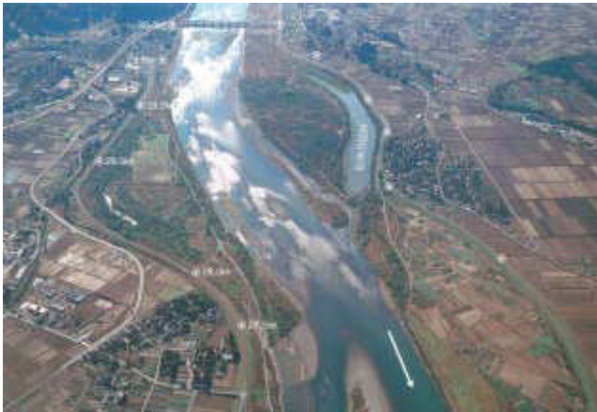
集団2 妙見堰 左岸 30.0km (下流より上流を望む)
