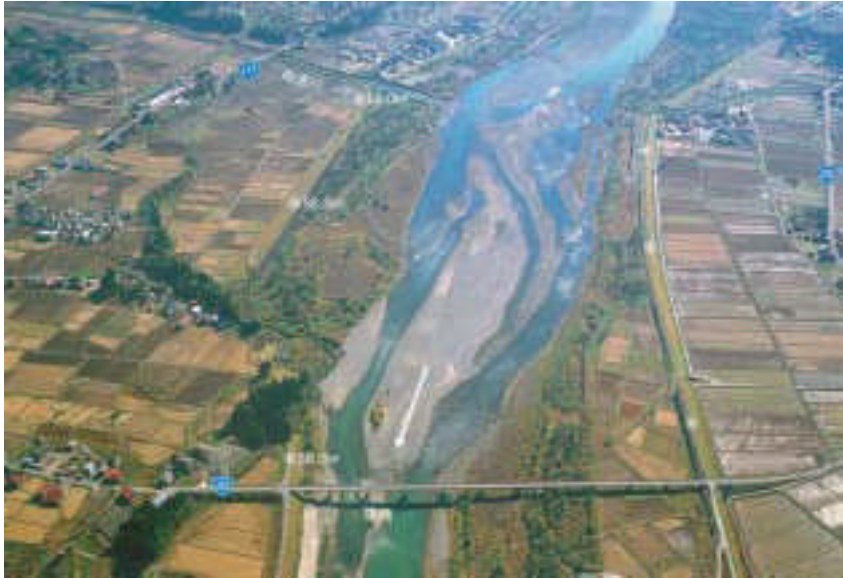
信信信7 栄橋 左岸 56.0~59.0km (下流より上流を望む)
