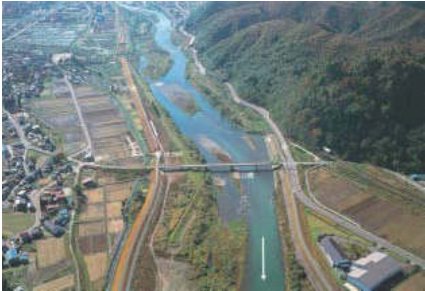
信魚信2 青島 左岸 15.0~18.0km (下流より上流を望む)
