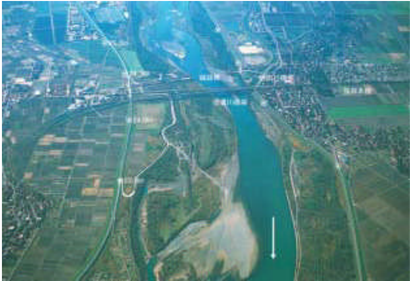
信信信4 越路橋 右岸 23.0~26.0km (下流より上流を望む)
