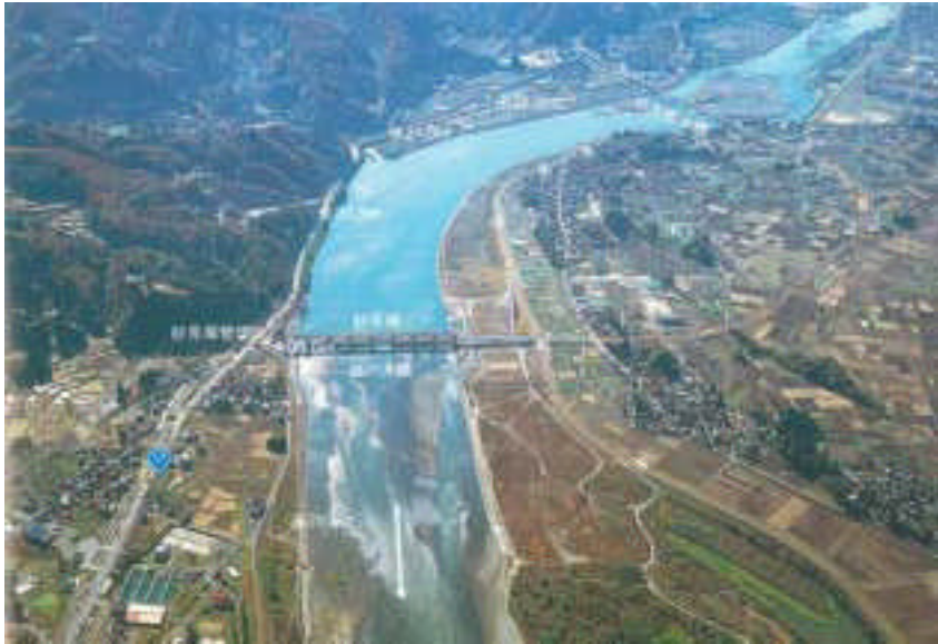
信信信5 小千谷大橋 左岸 30.0~33.0km (下流より上流を望む)
