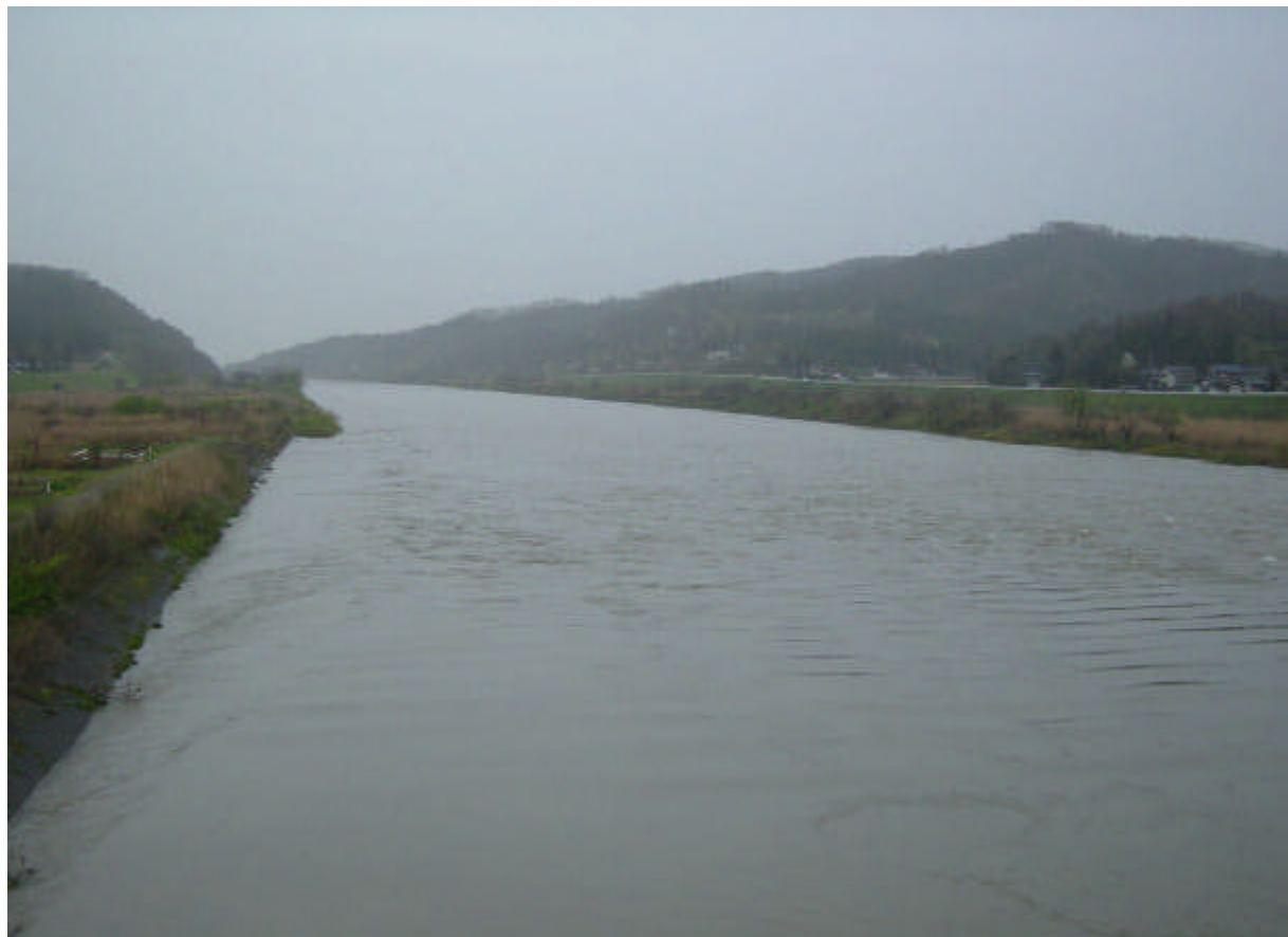
☆信大信1 渡部橋 両岸 3.2~3.4km (渡部橋より下流方向を望む)
