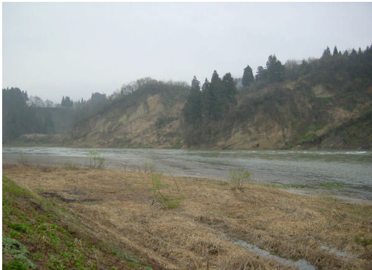
信信信4 上片貝 両岸 48.2~48.7km (左岸より下流方向を望む)
