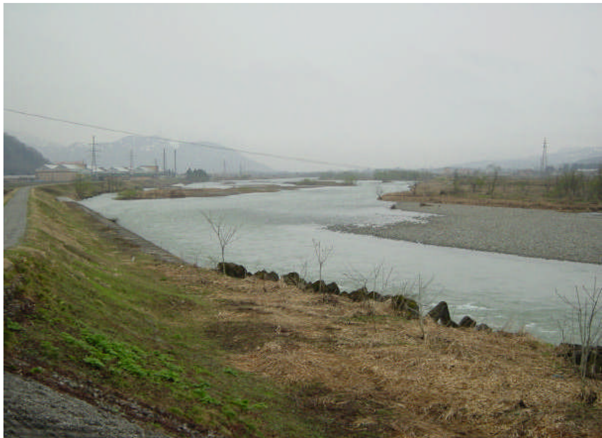
☆信魚信1 大和橋 右岸 24.7~25.0km (右岸堤防より上流方向を望む)
