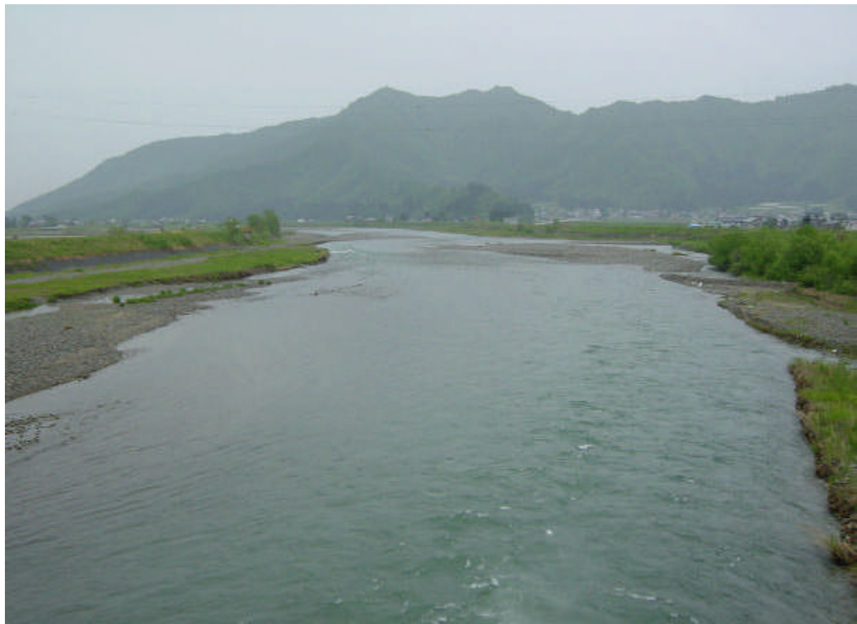
信魚六1 旭橋 その他 36.6~36.9km (旭橋より下流方向を望む)
