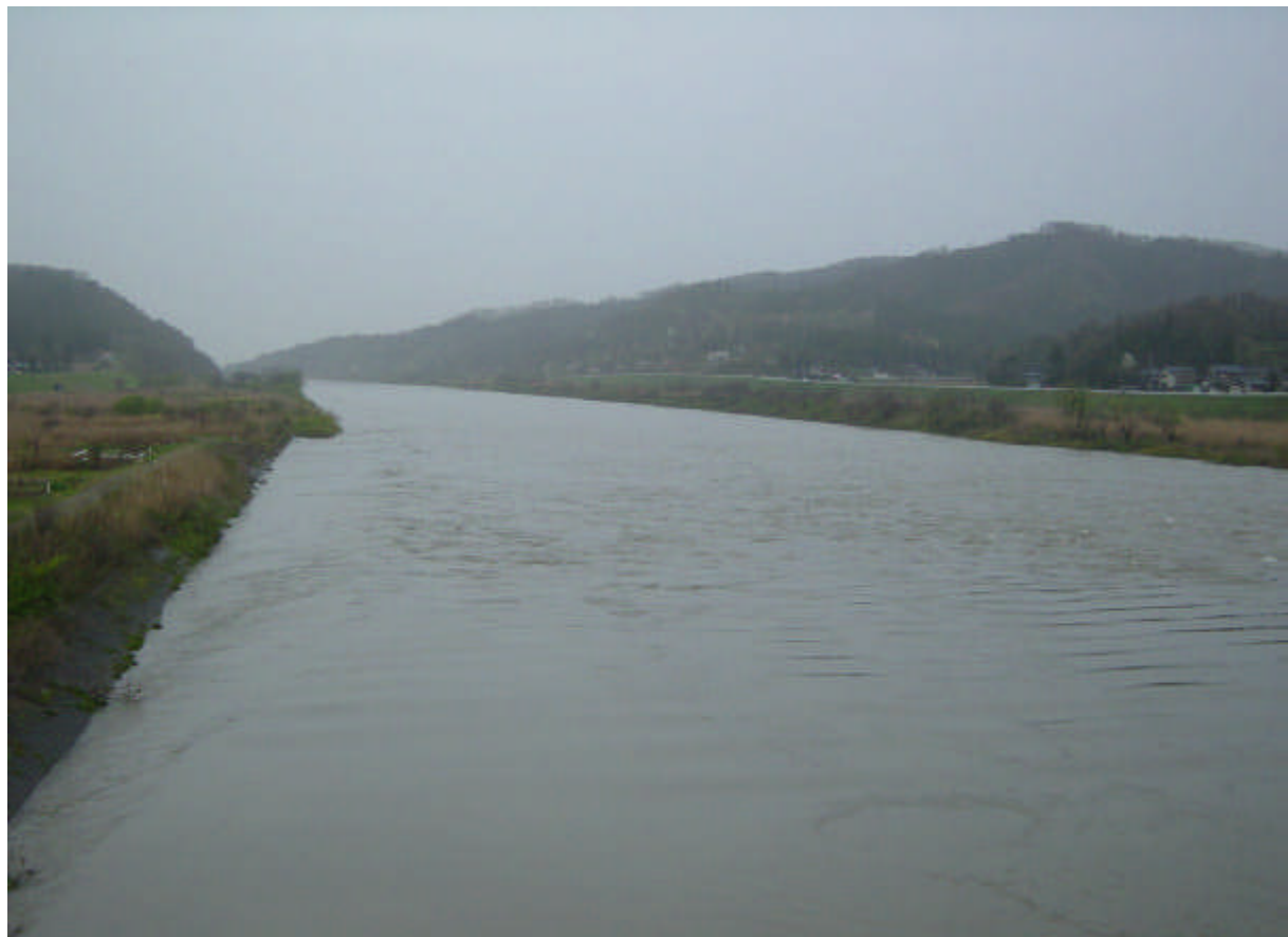
☆信大信1 渡部橋 左岸 3.2~3.4km (渡部橋より下流方向を望む)
