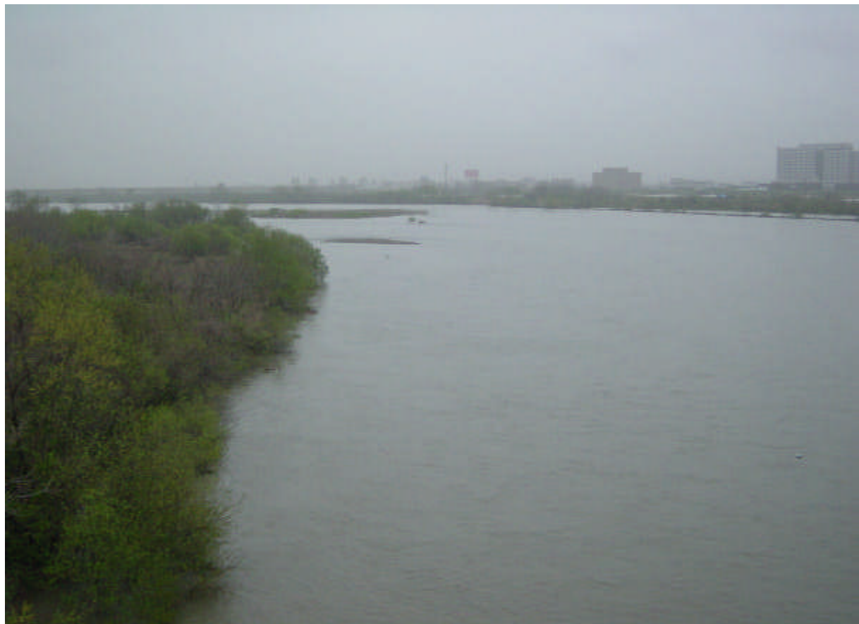
☆信信信2 長岡大橋 右岸 27.0~27.3km (長岡大橋より上流方向を望む)
