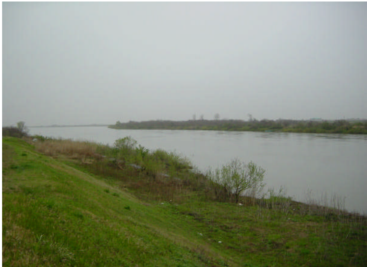
信信信1 馬越島 左岸 13.9~14.1km (旧黒川合流部より下流方向を望む)
