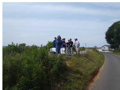
堤防断面不足の箇所を確認
