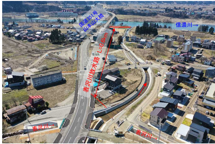
上流側から下流側を望む (撮影日:R2年3月9日)
