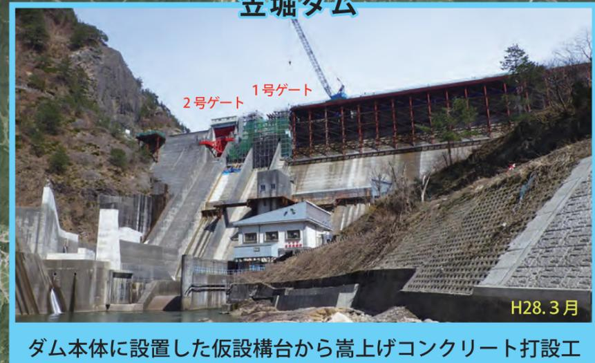
ダム本体に設置した仮設構台から嵩上げコンクリート打設工や、1号ゲート取替え工を実施しています。また、ダム基礎岩盤を補強するグラウチング工、県道嵩上工等も行っています。
