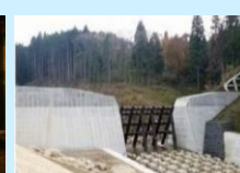
砂防関係施設整備
