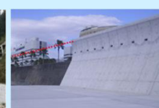
海岸保全施設整備
