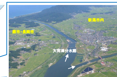
大河津分水路改修事業
