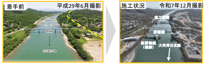
56:大河津分水路改修事業 (大河津分水路)
