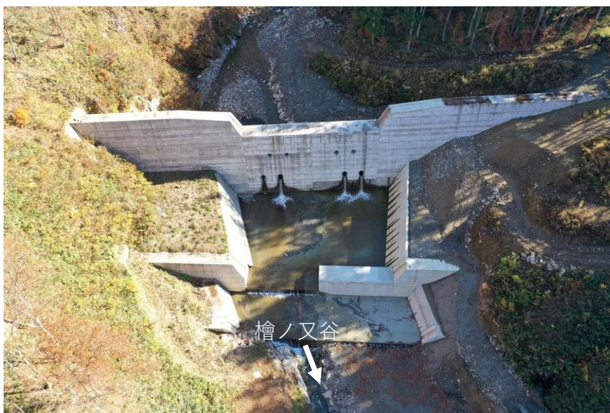
魚野川支川檜又谷で整備中の 「檜ノ又谷砂防堰堤」 (湯沢町土樽地区)
