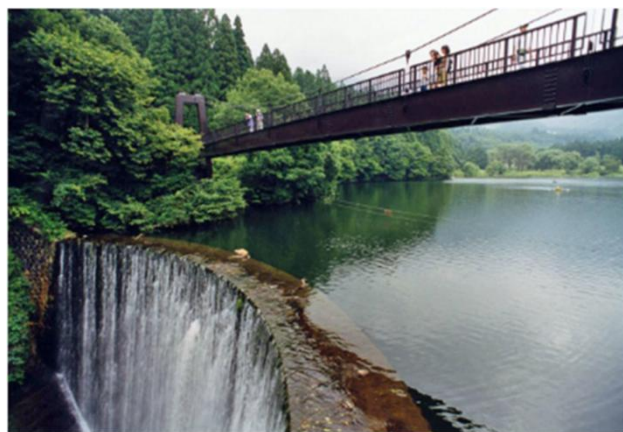
大源太川第1号砂防堰堤と湖畔周遊路
