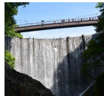
砂防堰堤正面となる仮排水トンネル吐口からの眺望
