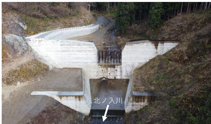
高棚川支川北ノ入川で整備中の 「北ノ入第2号砂防堰堤」 (南魚沼市長崎地区)
