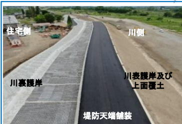
堤防強化(粘り強い河川堤防)
