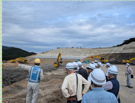
⑦大河津改修現場見学会
