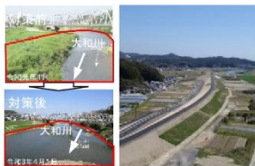
河川掘削・堤防整備
