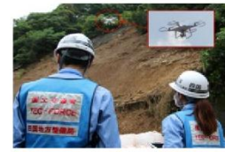
ドローンを用いた 被災状況調査
