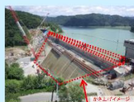
ダム建設・再生
