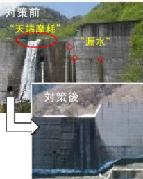
砂防堰堤の改築
