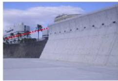
海岸保全施設整備
