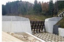
砂防関係施設整備
