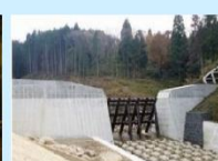
砂防関係施設整備
