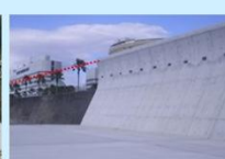
海岸保全施設整備
