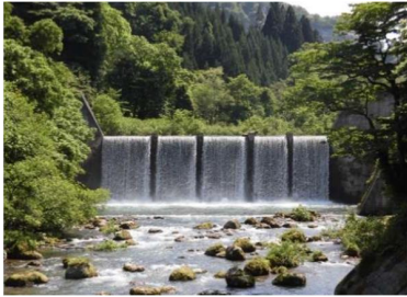
山形県大蔵村 舂玉砂防堰堤 (国土交通省 東北地方整備局)
