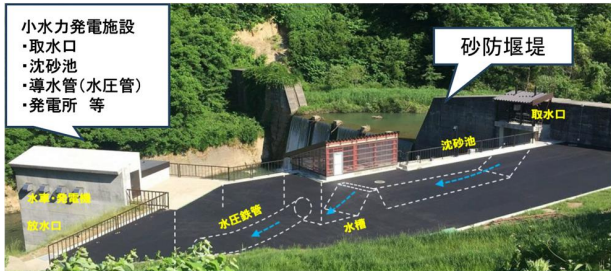
山形県大蔵村 おおくら升玉水力発電所
