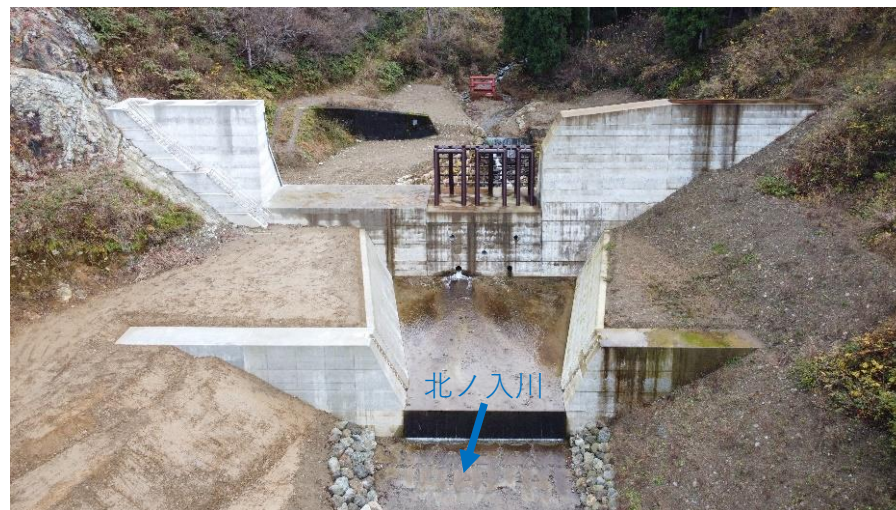
高棚川支川北ノ入川において整備中の 「北ノ入第2号砂防堰堤」 (南魚沼市長崎地区)
