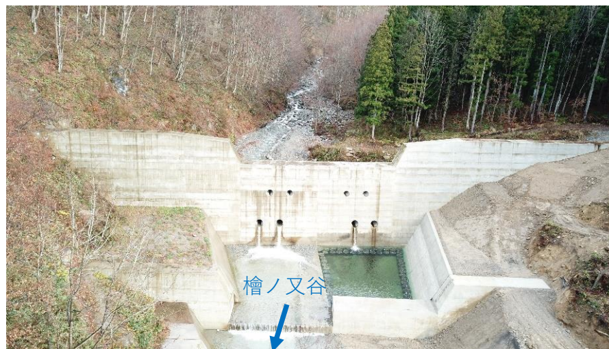
魚野川支川檜ノ又谷において整備中の 「檜ノ又谷砂防堰堤」 (湯沢町土樽地区)
