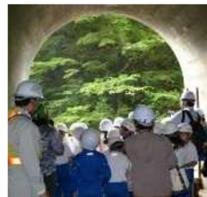
仮排水トンネル（吐口付近）
