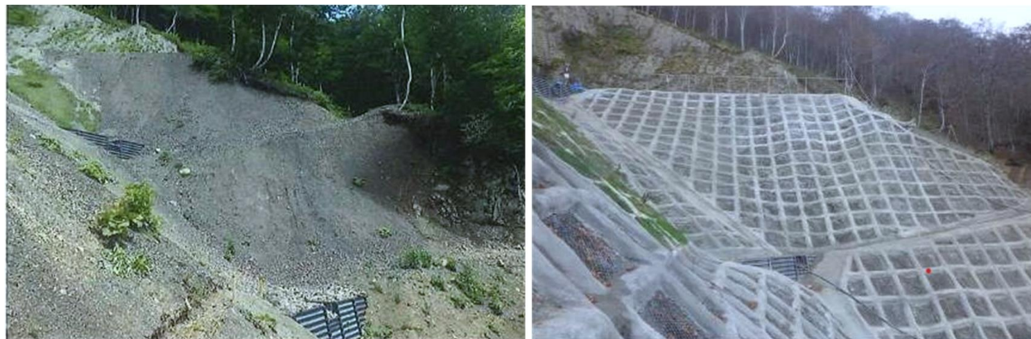
①山腹工施工前・後
