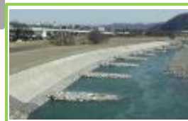
自然石を用いた巨石水制
