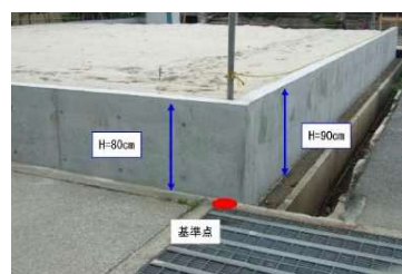
宅地かさ上げ状況
