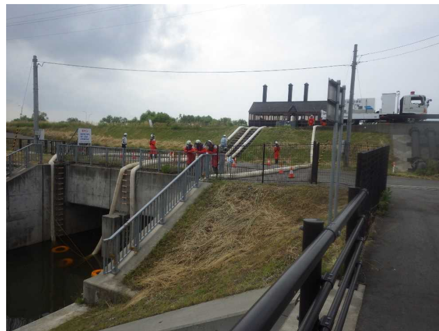
国による排水ポンプ車の訓練状況
