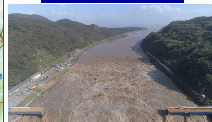
山地部掘削・低水路掘削
