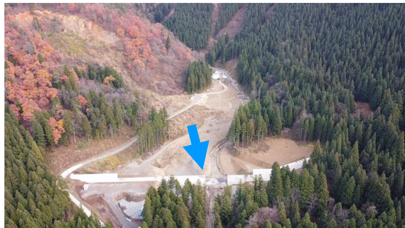
施工中の北ノ入第1号 砂防堰堤（手前）と 北ノ入第2号砂防堰堤 （奥）
