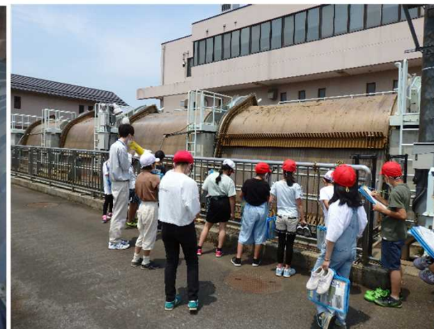
白根排水機場
