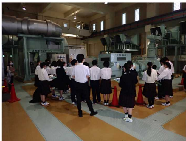
親松排水機場
