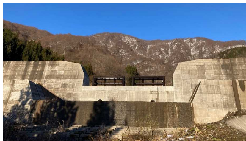
部分透過型へ改良工事が 完了し、土砂対策とともに 流木対策も向上させた 土沢第1号砂防堰堤
