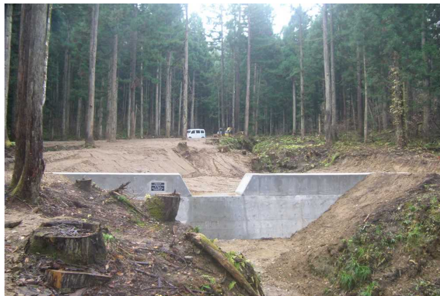
治山ダム及び森林整備の実施 (南魚沼市京岡地内)
