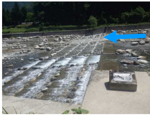
床固工の洗堀対策と合わせ 魚道の整備を実施
