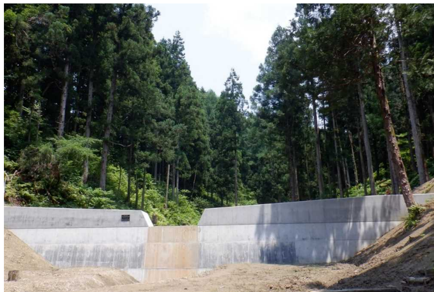
治山ダム及び森林整備の実施 (三条市麻布地内)
