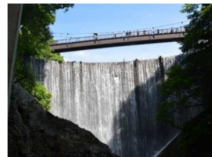
仮排水トンネル吐口からの眺望
