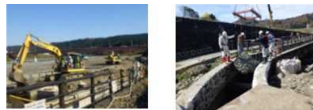
断水によるメンテナンスの様子
